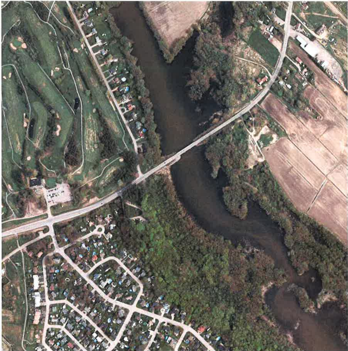
Carte 4. Orthophoto de la structure à remplacer et du milieu environnant
